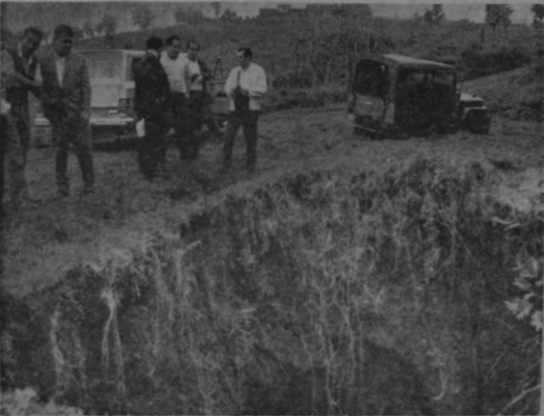
En el camino a Chocó en San Isidro de Coronado hace falta un muro de retención para evitar que la ruta sufra desviaciones. El Ministro
