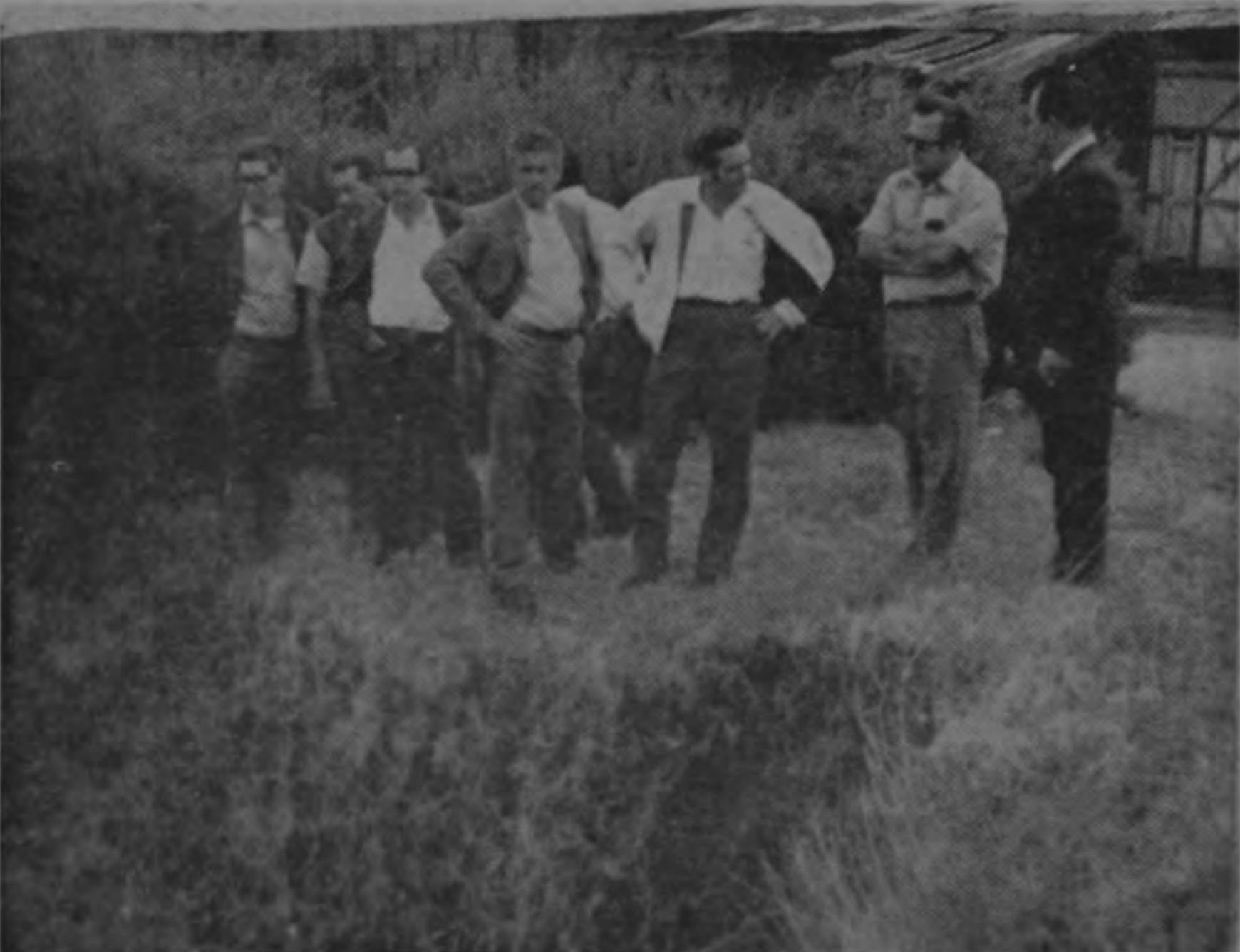
También en Coronado se observó la necesidad de construir un pequeño puente sobre la ruta 216 del Rio Virilla. El Ministerio de Trans-
